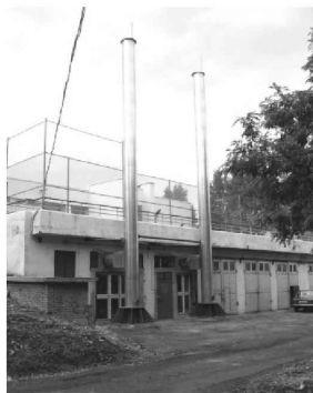
Котельная ВЭК. Студенты специальности «Тепловые электрические станции» знакомятся с оборудованием
