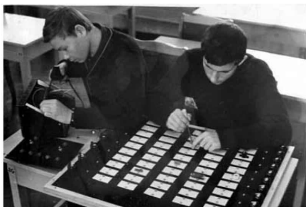
Учащиеся Василий Иванов и Виктор Ненаков за монтажом стенда для определения класса изоляции электроматериалов
