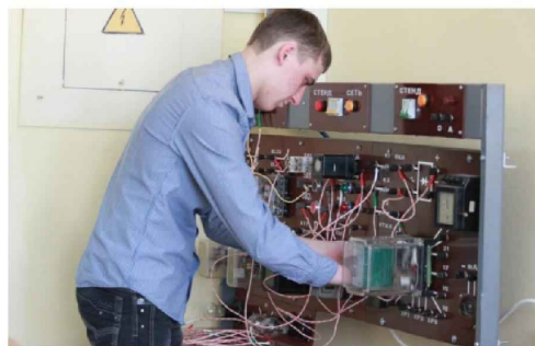
Тестовое опробование нового стенда «Эксплуатации и наладки устройств РЗА»
